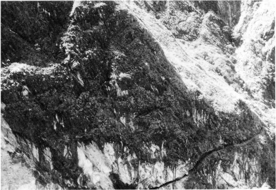
Abb. 2 : "Halbtunnel" südlich von Ghasa.
