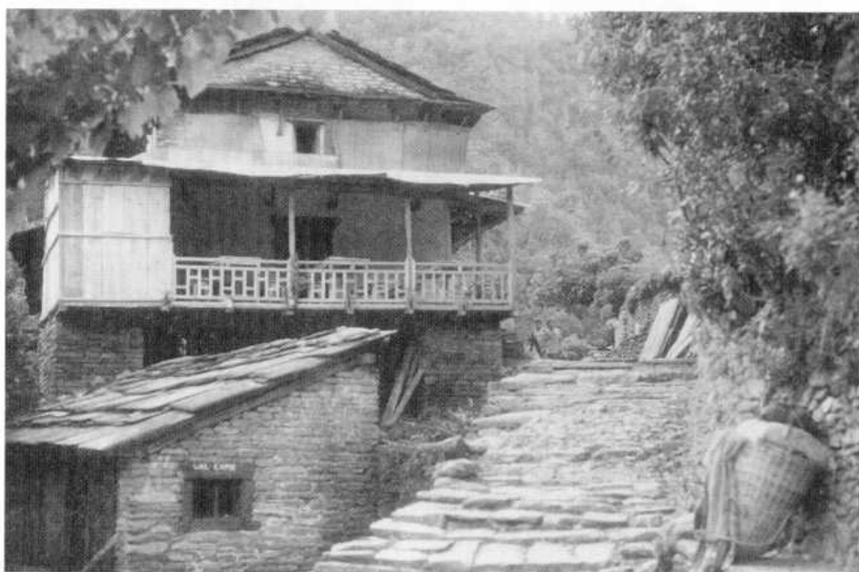
Abb. 6 : Gepflasterter Wegabschnitt mit Steinbank
