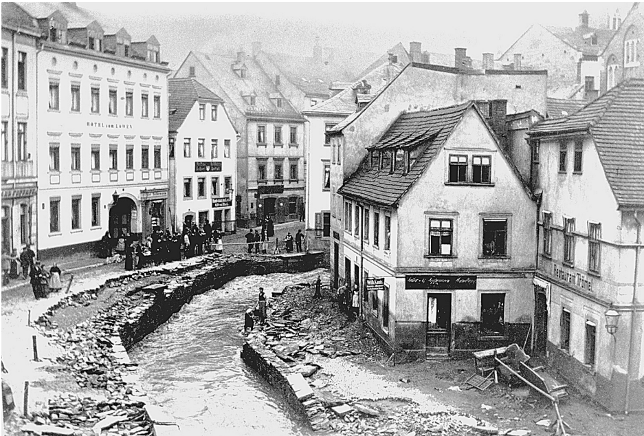
Abb. 11: Zerstörungen im Bereich des Töpfermarktes von Greiz (Thüringen) nach dem katastrophalen Hochwasser der Gräßlitz vom 6. Juni 1889 (Quelle: Sammlung Heimatmuseum Unteres Schloss, Greiz)
