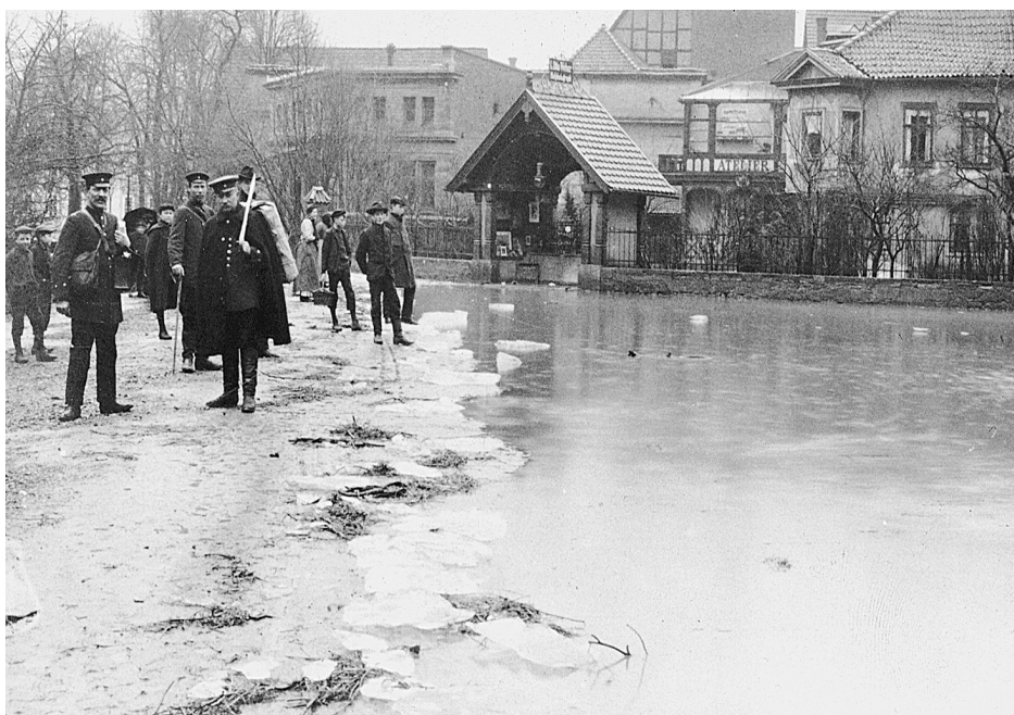
Abb. 8: Überschwemmungen im Stadtbereich von Meiningen (Thüringen) während des schweren Hochwassers der Werra Anfang Februar 1909
