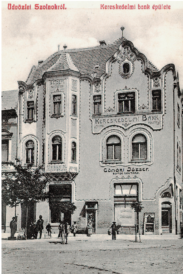
Abb. 10: Ein Bankgebäude in Szolnok (heute nicht mehr erhalten), 1908/09 im ungarischen Jugendstil von Dezső Jakab und Marcell Komor erbaut, auf einer Postkarte aus den 1900er Jahren
