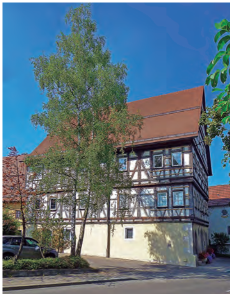
Abb. 2: Jebenhausener Sauerbrunnen 2016 Foto: V. Eidloth
